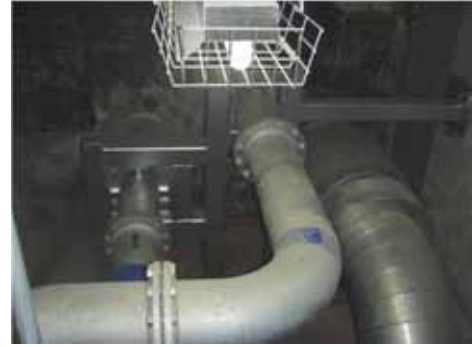
建屋接続部（奥：配管貫通部）
