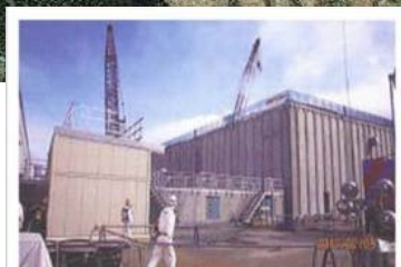
廃スラッジ一時保管施設
