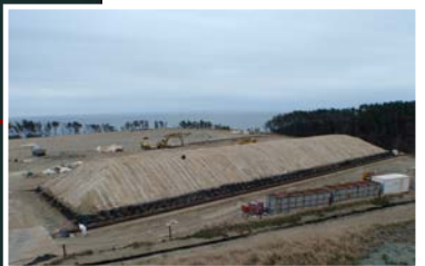
覆土式一時保管施設
