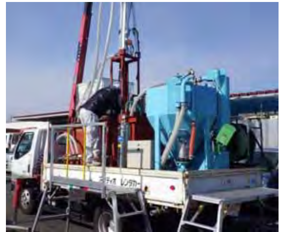
構外における浮遊物質除去プラントの組立状況
