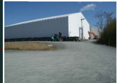
瓦礫保管テント
