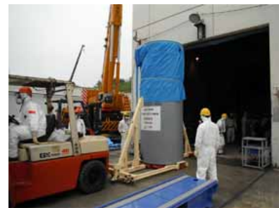
吸着塔搬入状況
