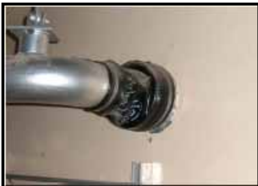
配管スリーブ貫通部
