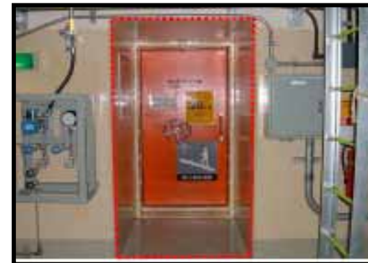
扉開口部 (建屋間ギャップ)
