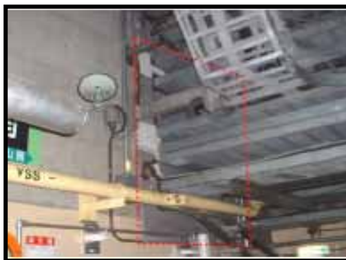
ケーブルトレイ貫通部 (トレンチ)
