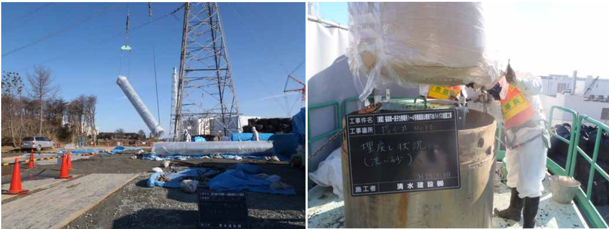
資機材の汚染防止対策
