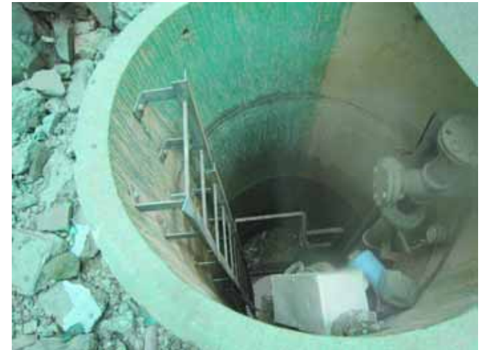
サブドレンピット内部（事故後）
