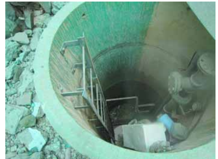
サブドレンピット内部（事故後）
