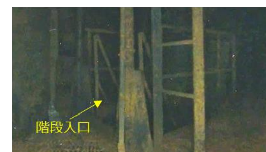
④：地下階段(南)
