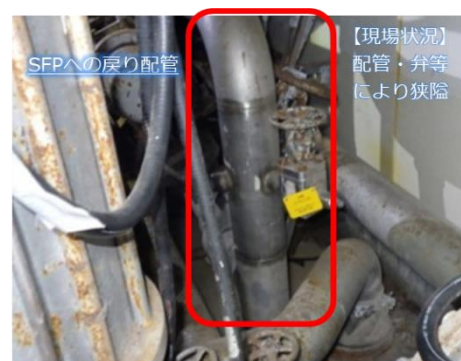
Rw/B1階 貫通部近傍現場状況
