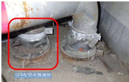
Rw/B1階 床貫通部(調査開始前)
