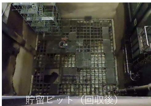
廃棄物供給室全景(事案発生後)
