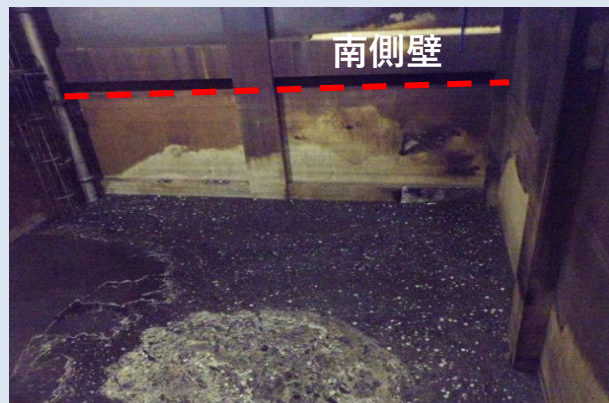
2024年7月27日時点(底部より約3.4m) 廃棄物貯留ピットの状況
