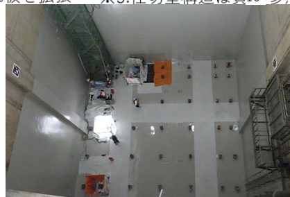
③ピットコンクリート補修後
