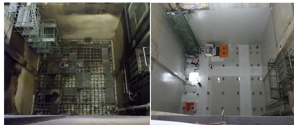
廃棄物貯留ピットの状況(左：補修前、右：補修後)
