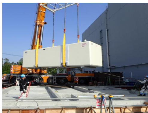
タンク設置作業の状況(2025年5月)
