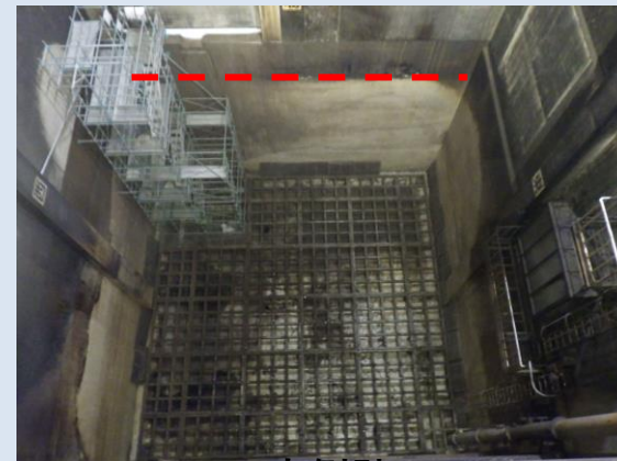
南側壁 2024年12月24日時点(回収完了後)
