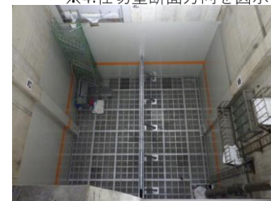
⑤ピット仕切壁設置後
