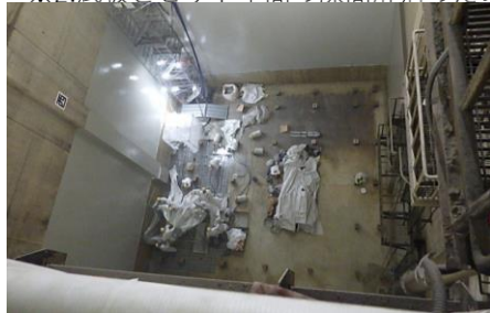
③ピットコンクリート補修中
