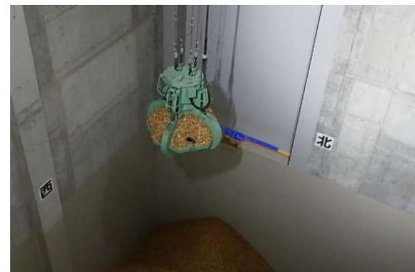
運転中のクレーンの様子
