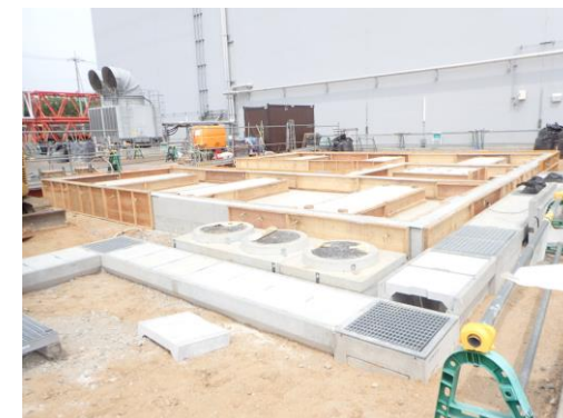
基礎設置作業の状況(2025年4月)
