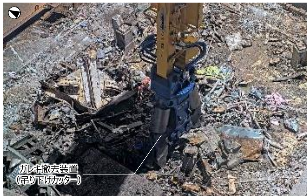
オペフロ上でのガレキ小割の状況 (撮影：2026年7月16日)
