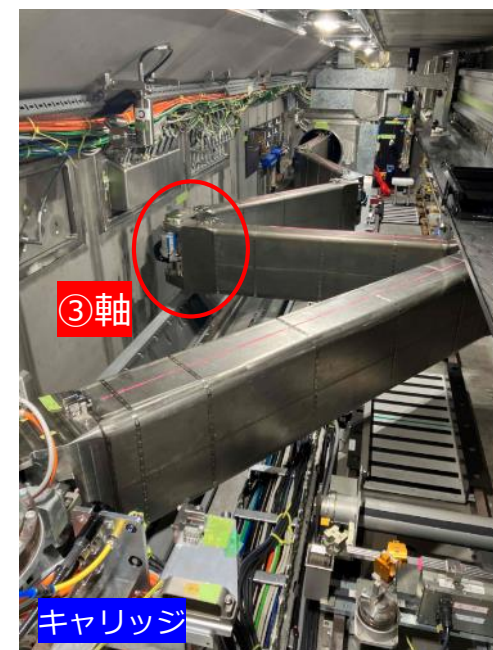
ロボットアーム動作状況 (楢葉検証時)
