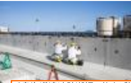
千島海溝津波防潮堤の仕上げ作業
