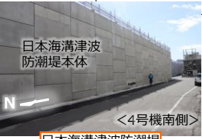
日本海溝津波防潮堤
