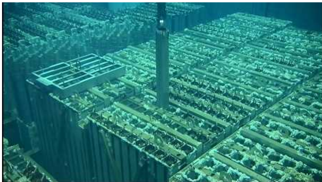
訓練で模擬燃料を吊り上げている様子 （撮影：2026年5月13日）
