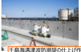
千島海溝津波防潮堤の仕上げ作業
