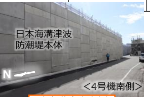
日本海溝津波防潮堤
