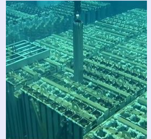
<2号機燃料取り出し訓練で模擬燃料を吊り上げている様子（撮影日：5月13日）>
