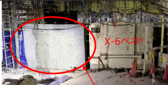
ジェットポンプ計装ラック (R/B 1階北西)
