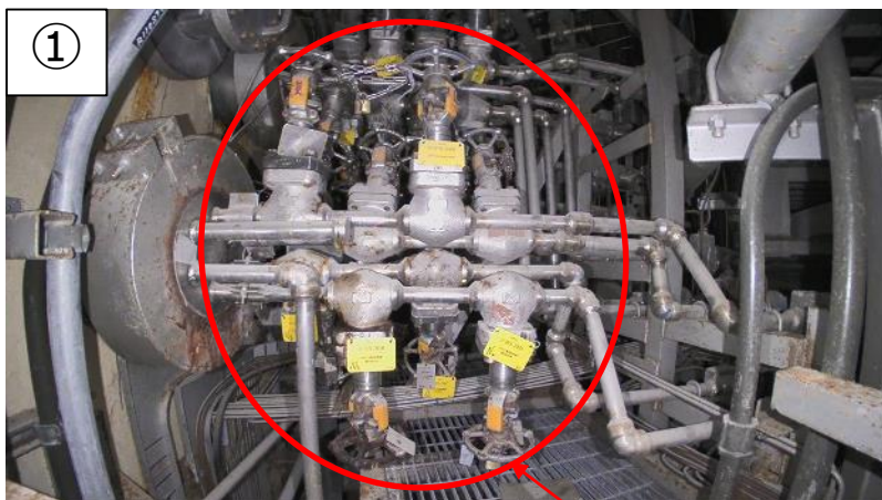
① 高圧注水系計装ライン
