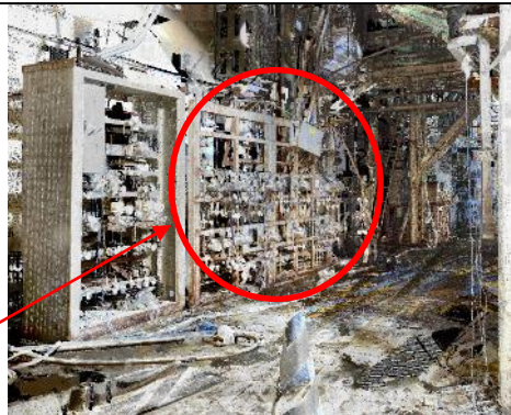
高圧注水系計装ラック (R/B 1階西)
