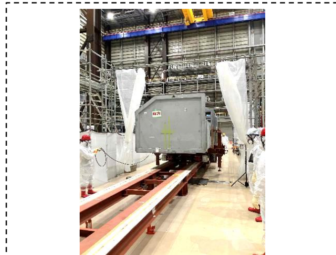
【運搬作業モックアップ時】※建屋内(模擬)から撮影
