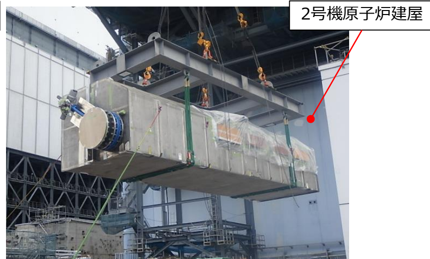
2号機原子炉建屋内に搬入
