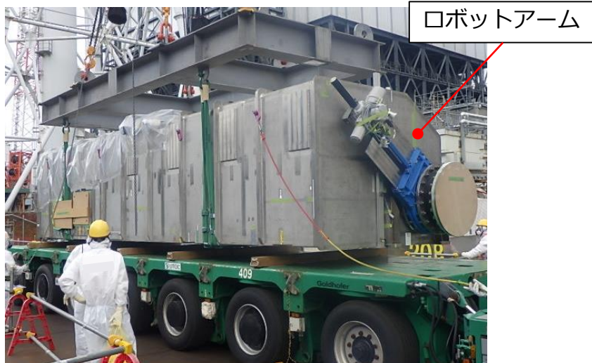
構内保管場所から2号機原子炉建屋に向けて搬送
