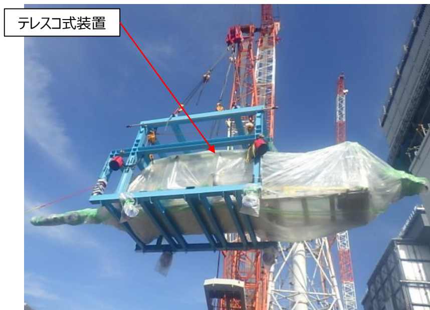
テレスコ式装置を原子炉建屋から搬出（11月5日）
