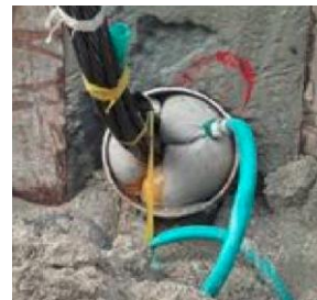
グラウンドアンカー口元止水
