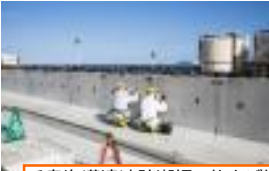
千島海溝津波防潮堤の仕上げ作業
