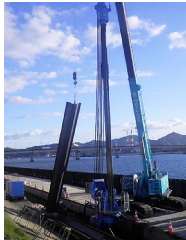
写真1 施工イメージ
