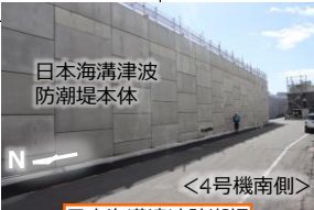
日本海溝津波防潮堤
