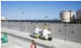
千島海溝津波防潮堤の仕上げ作業
