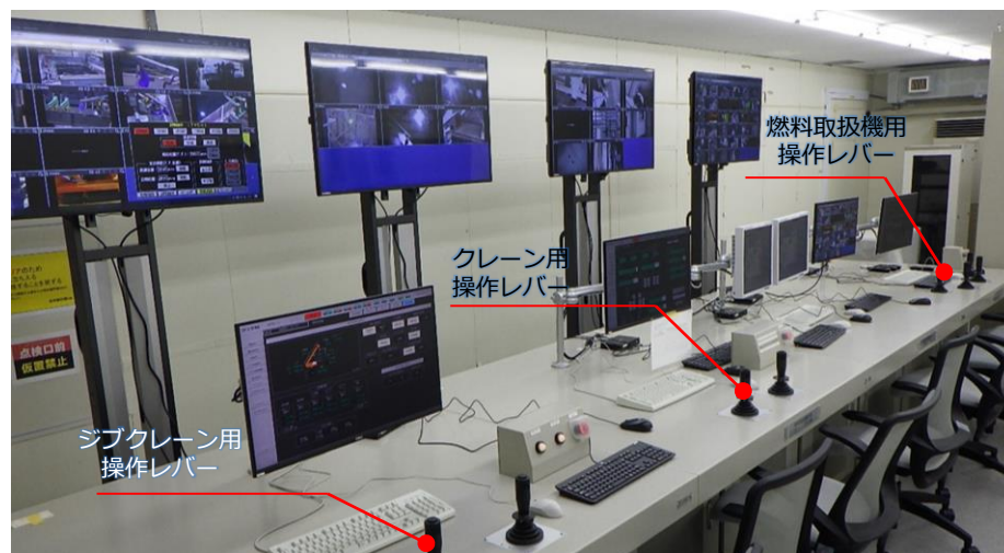
2025年8月22日 遠隔操作室設置状況
