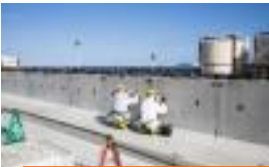
千島海溝津波防潮堤の仕上げ作業
