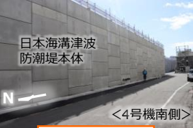
日本海溝津波防潮堤
