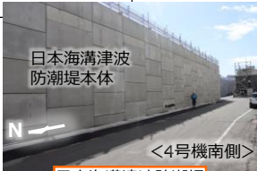
日本海溝津波防潮堤
