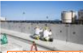
千島海溝津波防潮堤の仕上げ作業
