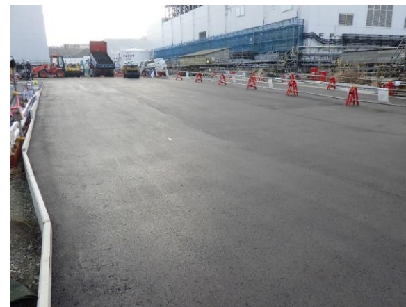
4号機原子炉建屋山側 敷地舗装
