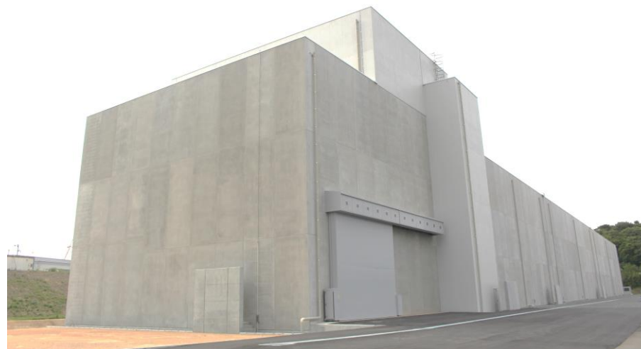
屋内保管 大型廃棄物保管庫
