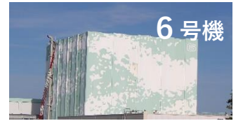
燃料取り出し実施中
