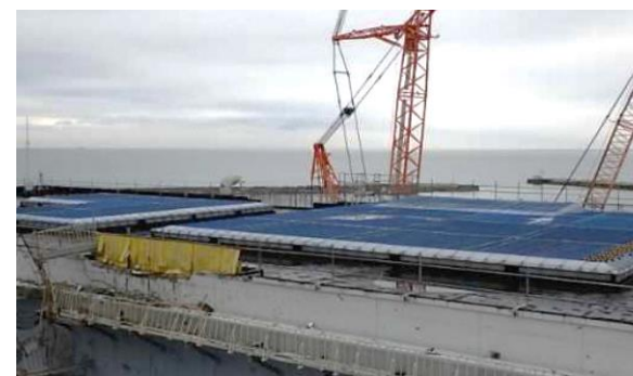
3号機タービン建屋 損傷部補修
