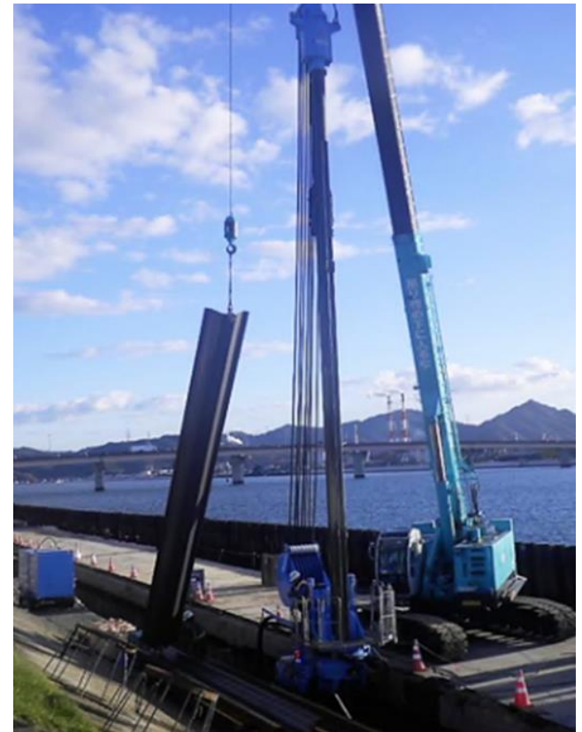
写真1 施工イメージ
