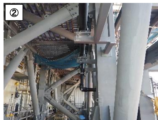
代替注水ライン設置状況（撮影：2月26日）
