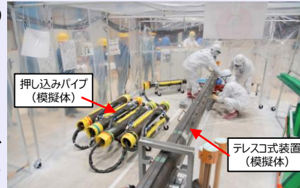
<模擬環境にて実施した押し込みパイプの作業訓練状況>
