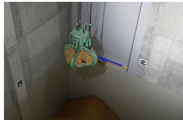
運転中のクレーンの様子
