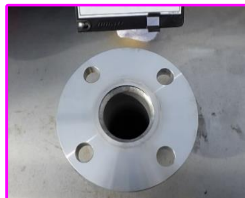
ベント管フランジ部（交換修理後）
