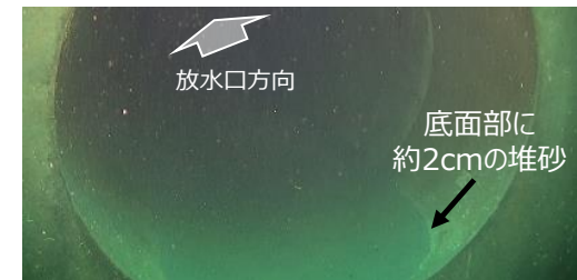
放水トンネル入口の状況
