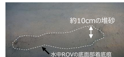
下流水槽底面部の堆砂状況
