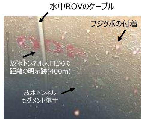
放水トンネル壁面の状況 (放水トンネル入口から400m地点)
