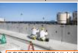
千島海溝津波防潮堤の仕上げ作業
