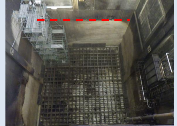
南側壁 12月24日時点(回収完了後)
