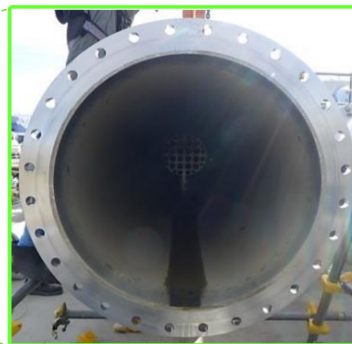
主配管（腐食等なし）
