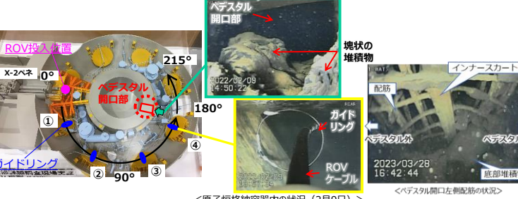
<原子炉格納容器内の状況 (2月9日)> <ペDESTAL開口部左側配筋の状況>
