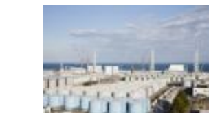
大型休憩所から見たタンクエリア（2015年10月29日）
