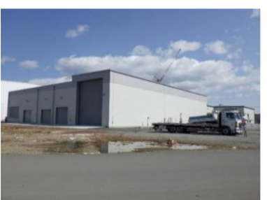
減容処理設備
