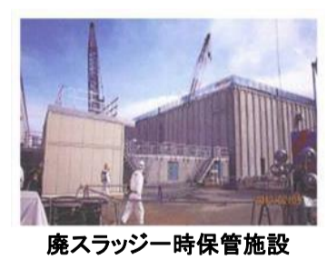
廃スラッジ一時保管施設
