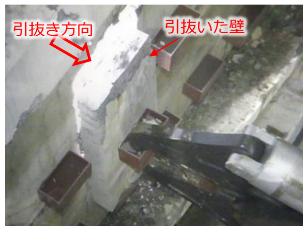
写真③：壁引抜き作業状況
