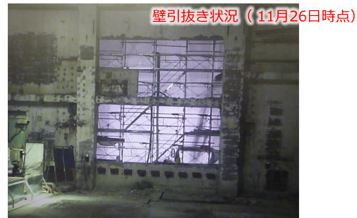
写真④：壁引抜き作業状況
