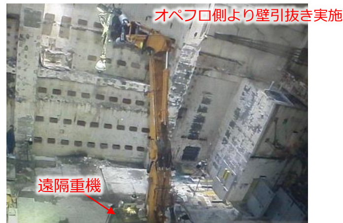
写真②：壁引抜き作業状況
