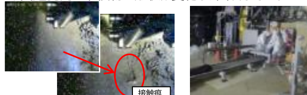
<接触前後の堆積物の状況> <貫通孔前での作業状況>
