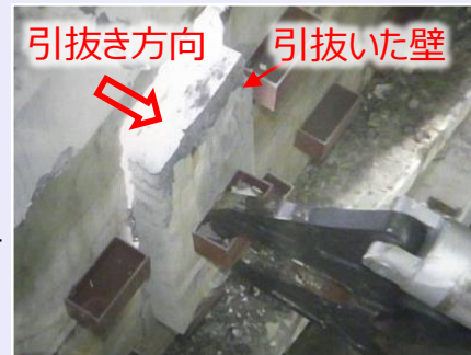
<壁引抜作業の様子>
