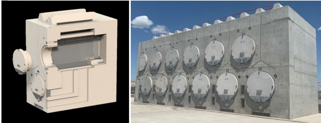
図 48 コンクリートキャスク 地上横置き保管タイプ 81
