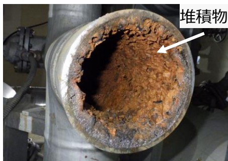
①切断面から上流側を撮影
