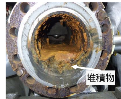
④フランジから下流側を撮影
