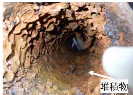
②切断面から下流側を撮影
