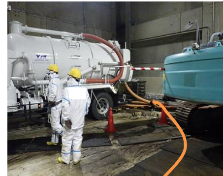
パワープロベスターでの水回収
