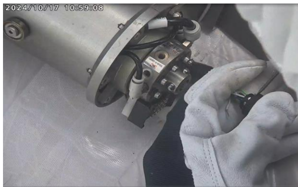
先端治具監視カメラ（カメラ①）の作業状況
