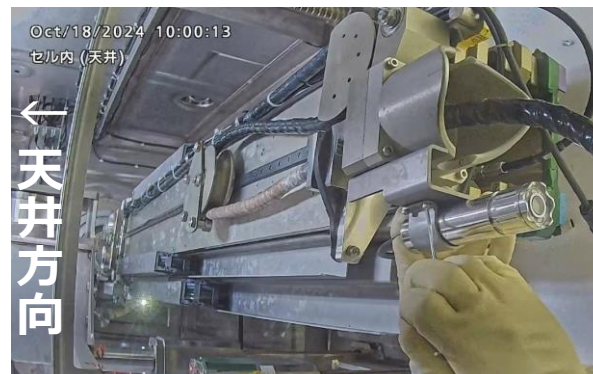
アーム先端部カメラ（カメラ②）の作業状況
