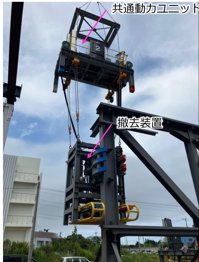
柱切断状況 (撮影:8月7日)
