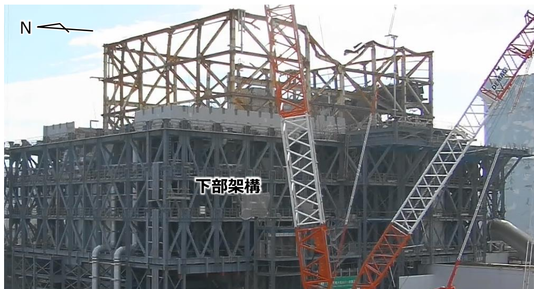
現場状況（北西面） （撮影：10月29日）
