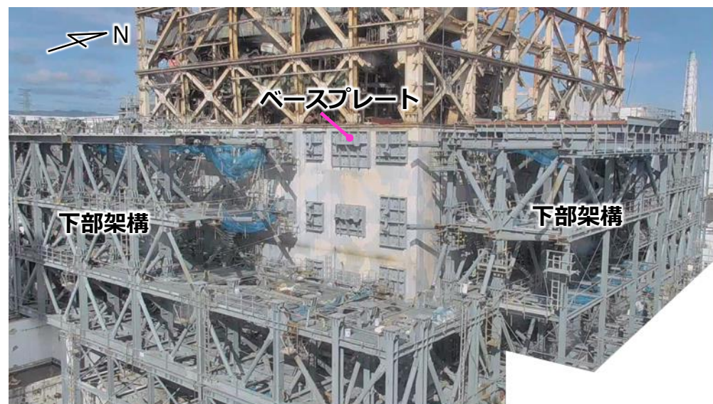
現場状況（南東面） （撮影：10月29日）
