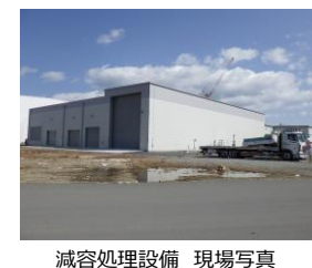
減容処理設備 現場写真
