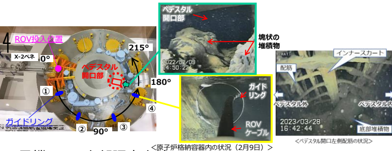
<原子炉格納容器内の状況 (2月9日)>
