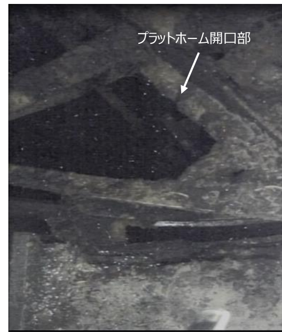
テレスコ式アームカメラの画像 (ペDESTAL開口部、プラットホーム開口部の状況)
