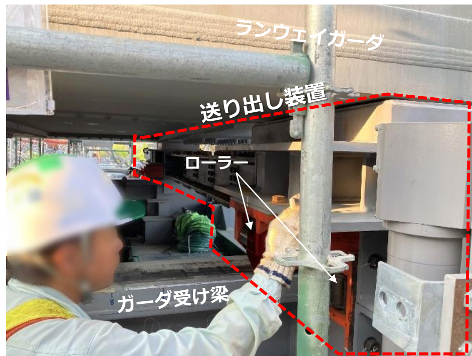
ランウェイガーダ送り出し状況 (撮影2024.8.5)
