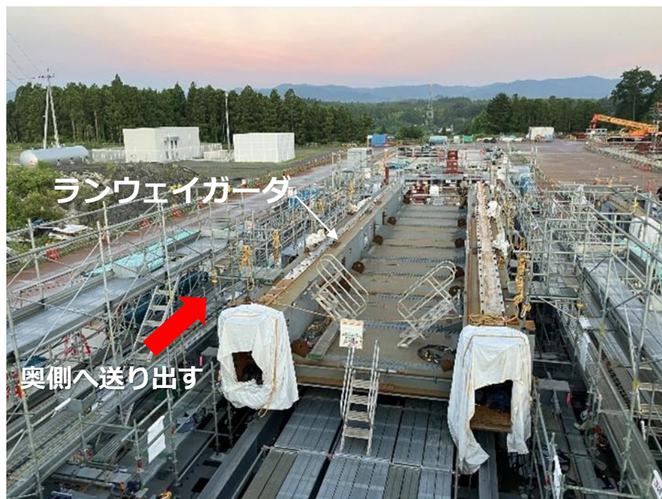
ランウェイガーダ送り出し状況 (撮影2024.8.1)
