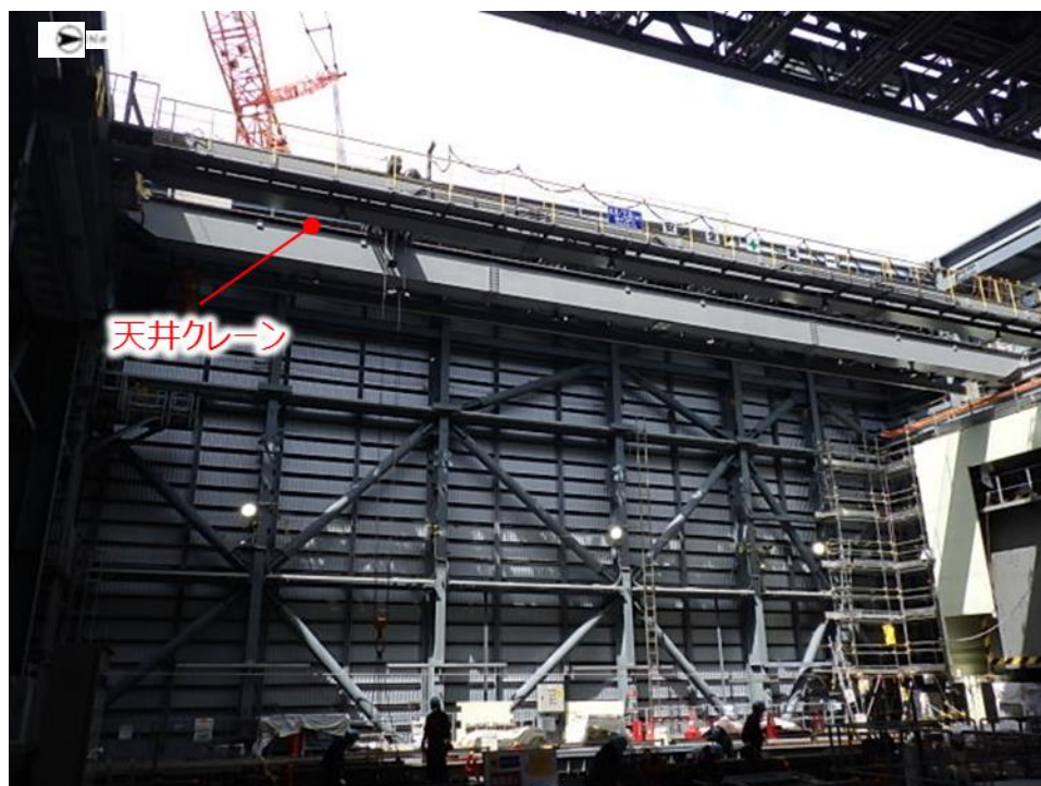
天井クレーンの設置状況 (撮影2024.8.27)
