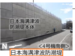
日本海溝津波防潮堤
