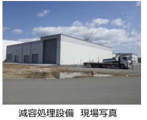
減容処理設備 現場写真
