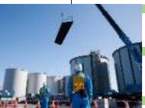
溶接タンク建設中の様子
