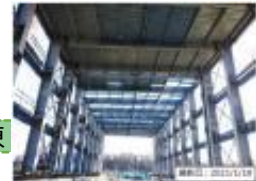
大型廃棄物保管庫第一棟 屋根工事の状況（内部より）
