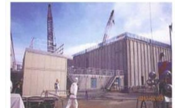
廃スラッジ一時保管施設
