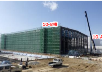
固体廃棄物貯蔵庫第10棟
