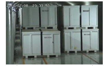
固体廃棄物貯蔵庫
