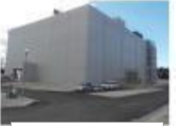
雑固体廃棄物焼却設備
