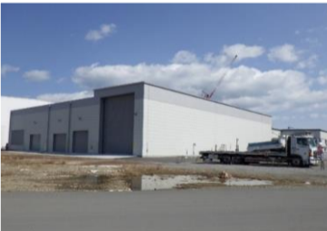
減容処理設備
