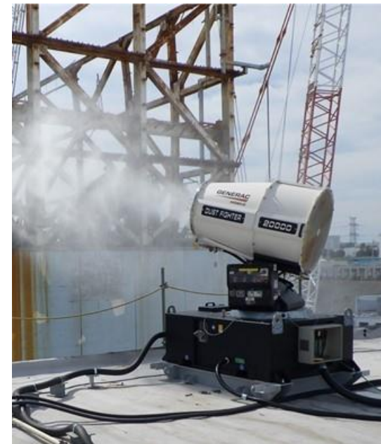
噴霧装置による散水状況
