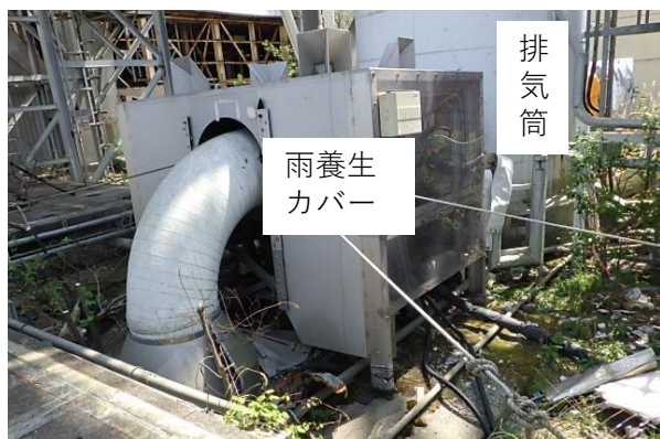
排気筒サンプ周辺状況
