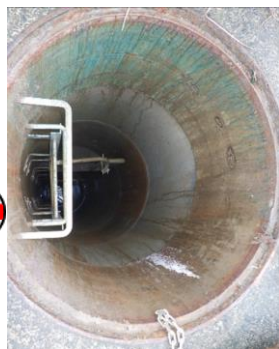
水面はマンホール上部から5m以上、下部にある (目測)
