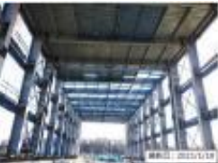
大型廃棄物保管庫第一棟 屋根工事の状況（内部より）
