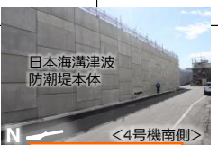
日本海溝津波防潮堤
