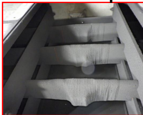
事故点より南へ約2m 箇所内部写真
