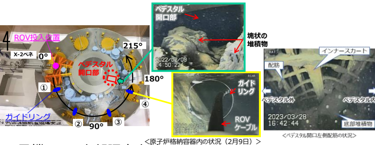
1号機 PCV内部調査実績
